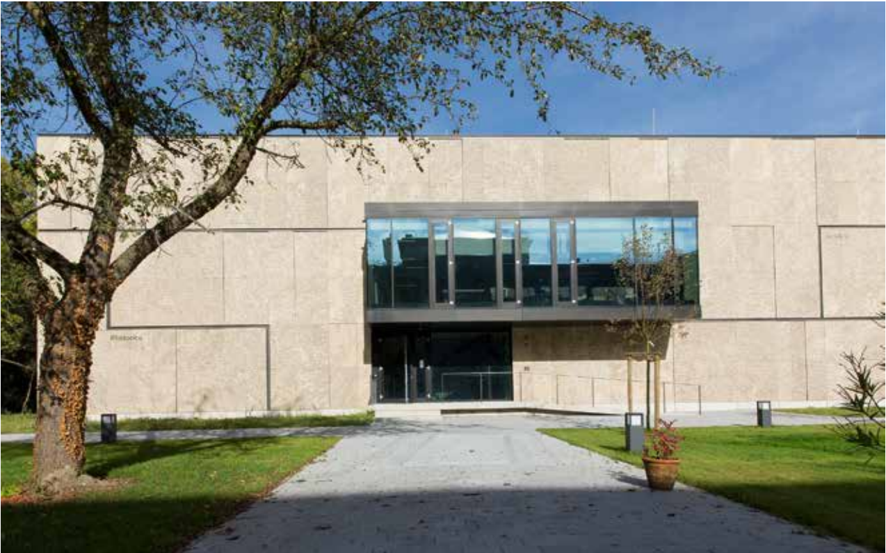
Impressionen vom Magazinneubau (über die Grundsteinlegung berichteten wir in der AUGUSTA 2012)
